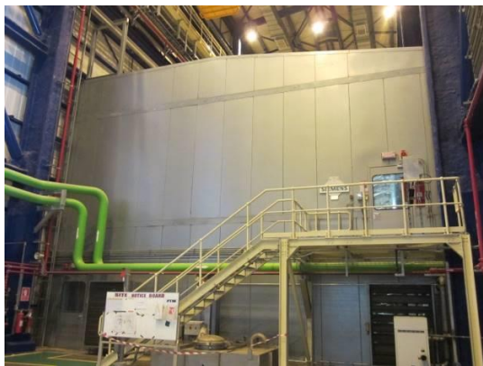
รูปที่ ข.3-1 การติดตั้งชุดลดเสียง (Silencer)
