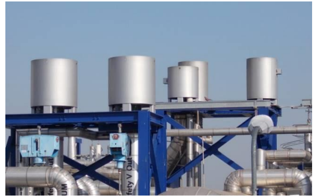
รูปที่ ข.3-1 การติดตั้งชุดลดเสียง (Silencer)
