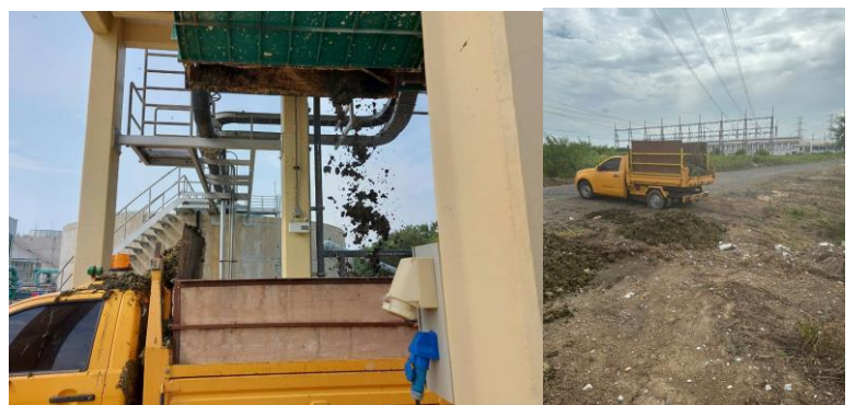
(ข) ตัวอย่างการนำตะกอนที่ดูดขึ้นมาจากบ่อพักน้ำ ทากตะกอนจาก ระบบปรับปรุงคุณภาพน้ำไปถมที่ลุ่มภายในโรงไฟฟ้า
